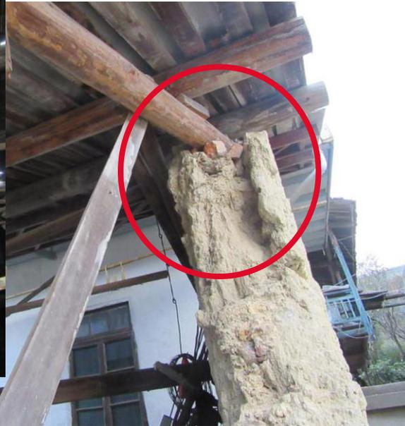
支承处土墙裂缝宽度大于10mm（右已崩塌）
