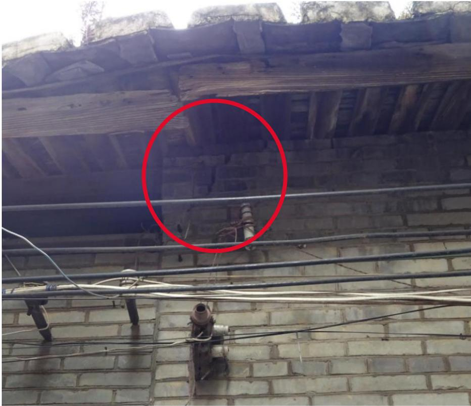
支承处砖墙裂缝宽度大于1mm
