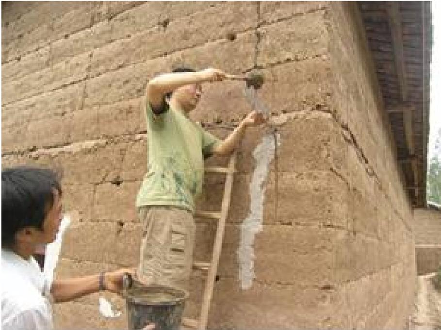
裂缝宽度较小时，可采用水泥浆、石膏浆或水玻璃等材料灌缝处理
